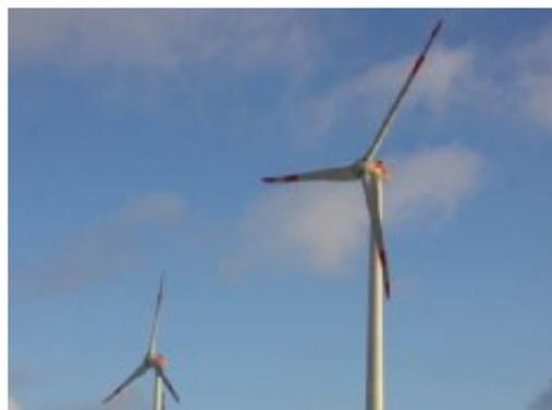
Da die Generatoren der Windkraftanlagen bei Ettelscheid Brummtöne verursachen, sollen sie ausgetauscht werden.
