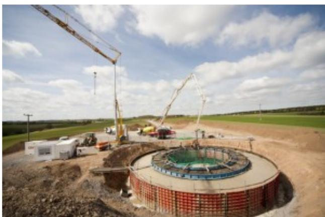
922 Kubikmeter Beton werden in die Schalung gepumpt. Bild: Tameer Gunnar Eden/Eifeler Presse Agentur/epa
